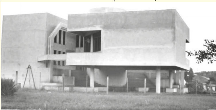
Construção da sede - Acervo ACIME
